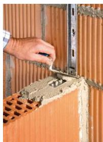
Kraftschlüssiger Wandanschluss an eine bereits vorhandene Wand, schnell und günstig hergestellt ohne mühevoll eine Verzahnung aus der bestehenden Mauer ausubrechen. Dabei können Höhe und Anzahl der Verbinder-Anker beliebig im Schienensystem variiert werden. Dies erspart Schmutz, Lärm und vor allem Arbeitszeit. Der stumpf gestoßene Wandanschluss ist für alle Steinbreiten und Mauerwerkarten geeignet.
