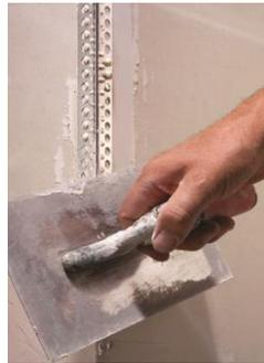
Das Eckprofil für den Trockenbau dient dem Schutz von Kanten und Ecken gegen mechanische Beschädigungen. Es wird in verschiedenen Ausführungen hergestellt und muss zur Plattenmitte hin verspachtelt werden. Das Eckprofil wird im Trockenbau wie auch für dünne Putzbeschichtungen eingesetzt.
