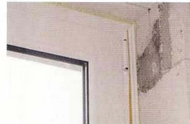
2 Die Lasche zur Befestigung der Schutzfolie ist flexibel, so dass auch Fensterscharniere sehr einfach verklebt werden können. Die Lasche kann ohne Messer entfernt werden. Dann sorgt eine elastische Weichlippe für eine gelungene Optik.
