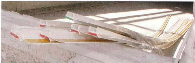
1 Anschlussprofile jeweils für innen und außen für einen technisch einwandfreien Fensteranschluss. Zur besseren Unterscheidung sind die Schaumklebebänder grün und rot eingefärbt.
