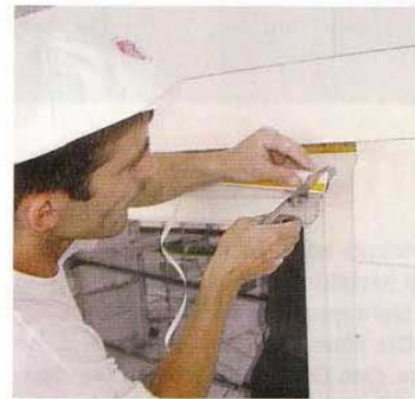
3 Am besten werden die Ecken mit einer Gehrungsschere zurechtgeschnitten.
